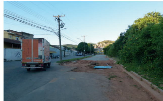
Agora vai! Prefeito Paulo Ney garante conclusão da obra.
